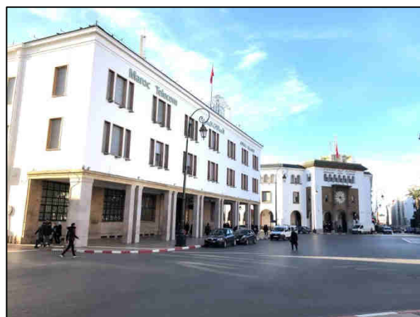
Localisation du Musée sur le Boulevard Mohamed V, Place de la Poste, avec au fond la Grand Poste de Rabat RP
