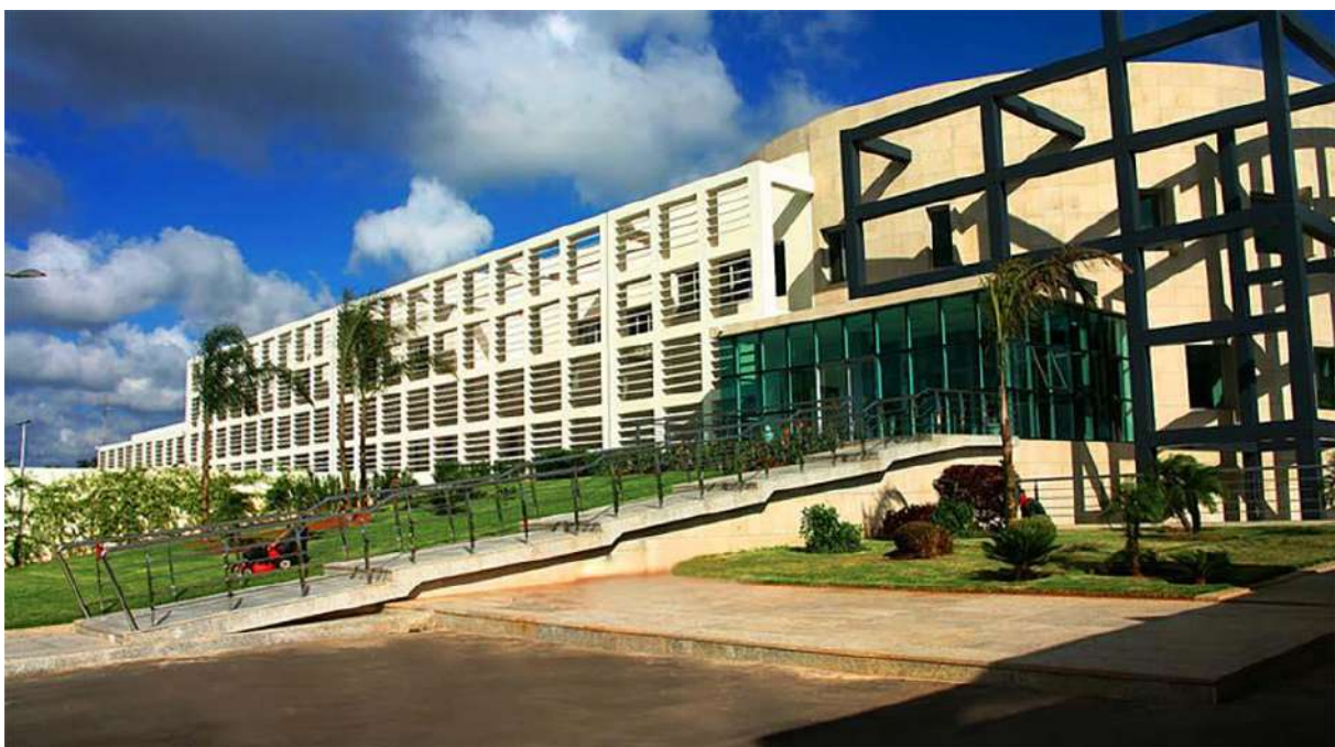
Dar Assika (Maison de la Monnaie) de Bank Al Maghrib, Salé
