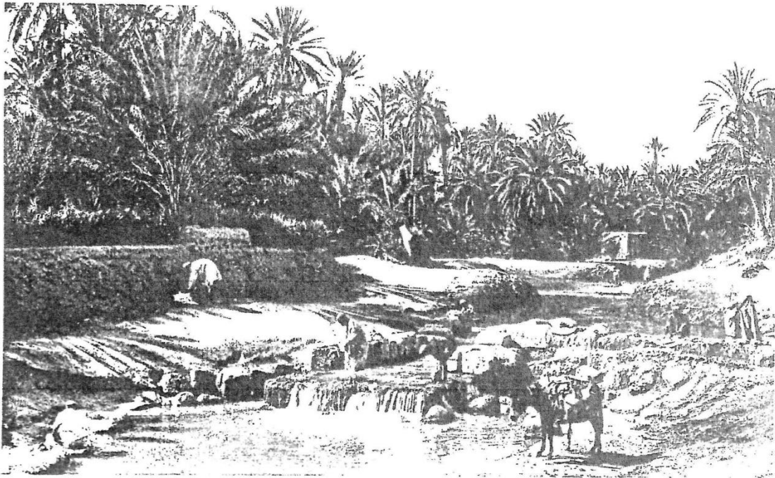
1240 TOZEUR - Un Barrage sur l'Oued
