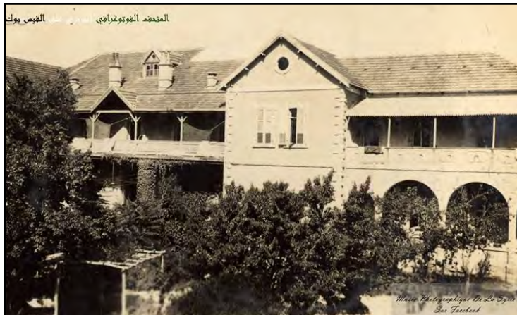
الواجهة الجنوبية المصدر: متحف دمشق الفوتوغرافي
