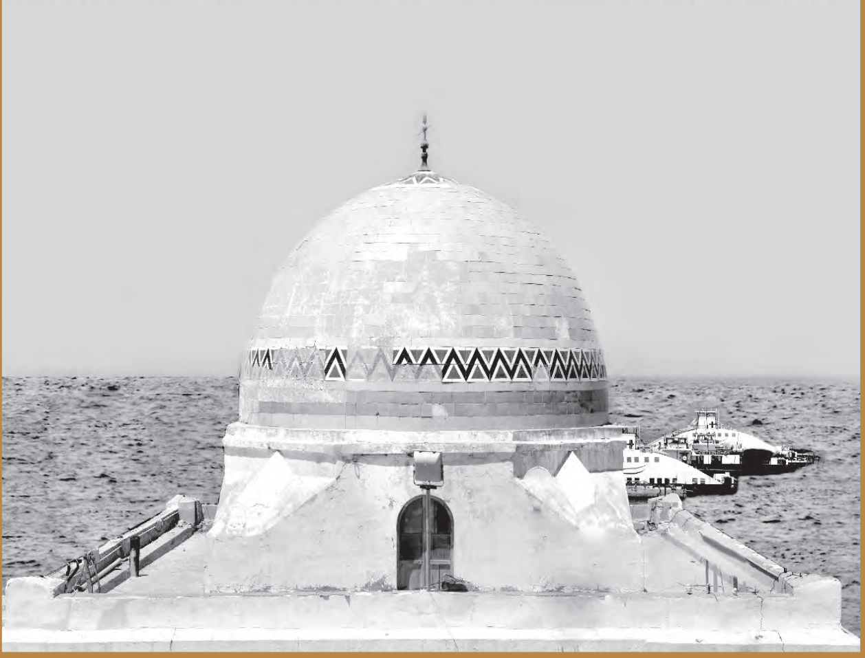
منظر عام للقبة الوسطى من الواجهة الشرقية والواجهة الغربية، وشكل تفصيلي لشعار قناة السويس من الواجهة الغربية على إثر تعريبه بعد تأميم الشركة.
